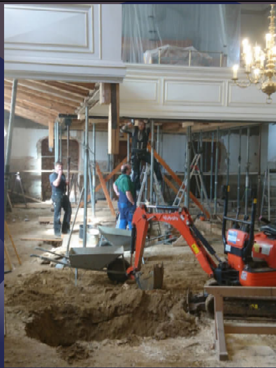
4. Mai 2021 die Zimmerer kommen mit dem Bagger
