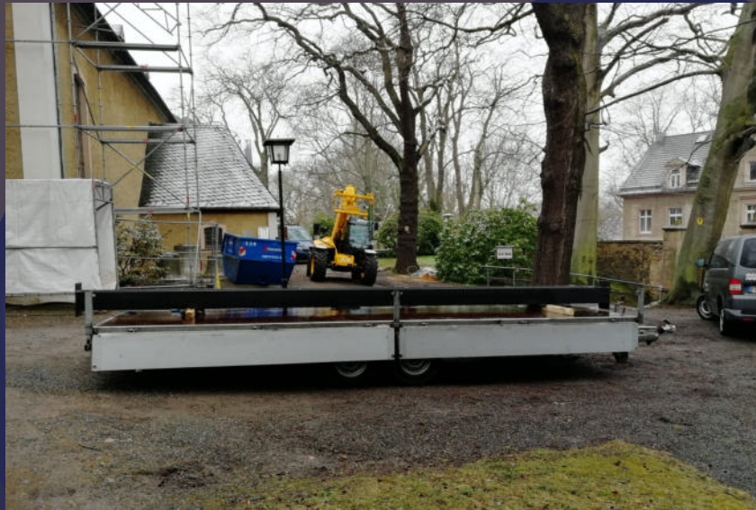
16. April 2021 Thiemes vom Metallbau Raschke aus Auerswalde liefern die Stahlträger an
