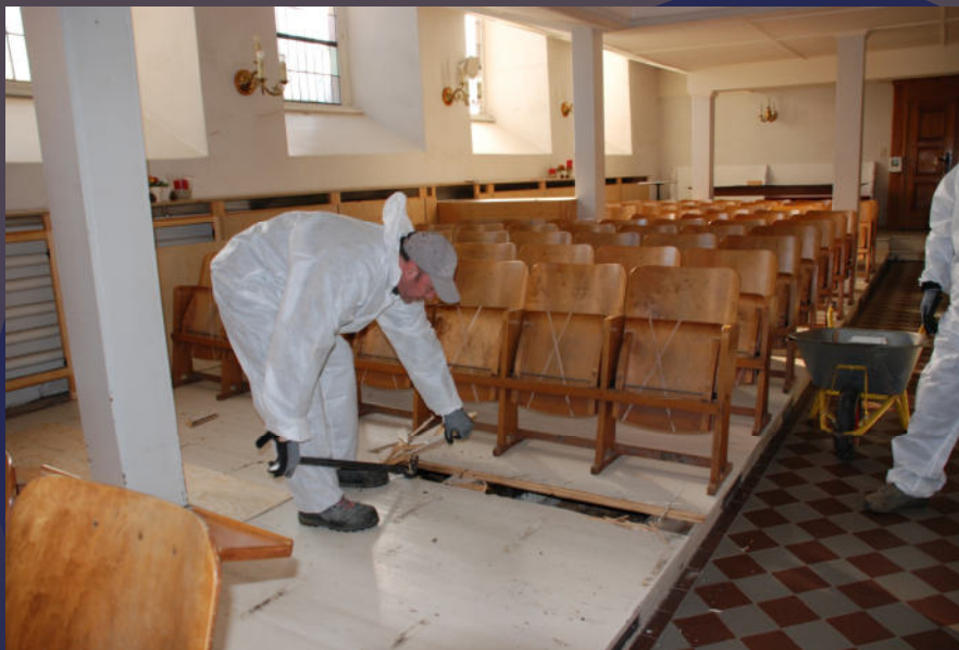
8. Februar 2020: der Rückbau beginnt ...
