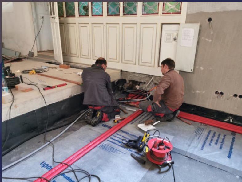
26. August 2021 die Heizungsbauer Herr Gießner und Herr Naumann
