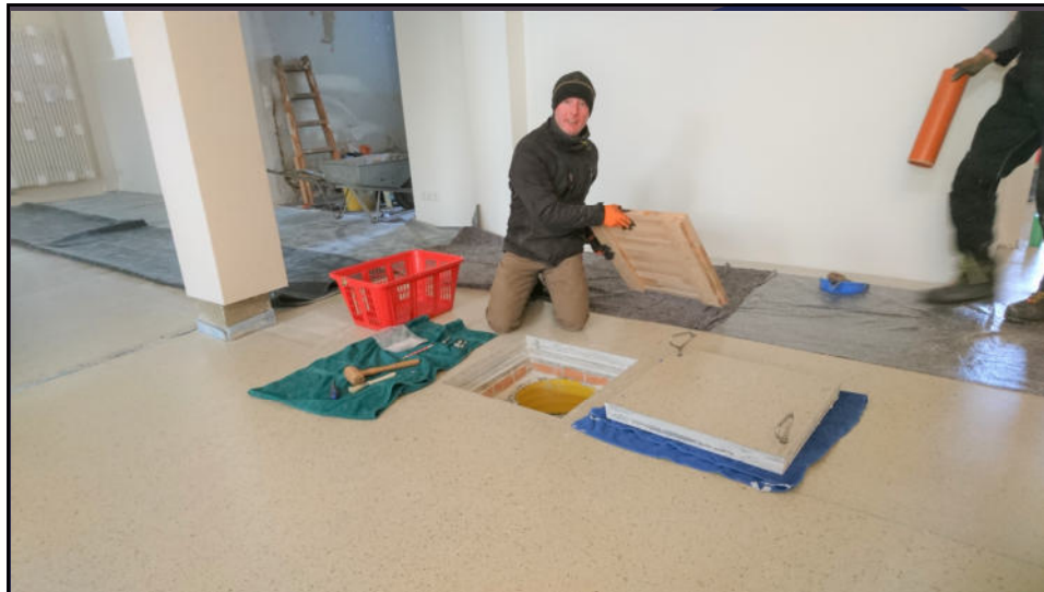
4. Dezember 2021 Arbeiten am Medien-Schacht ...
