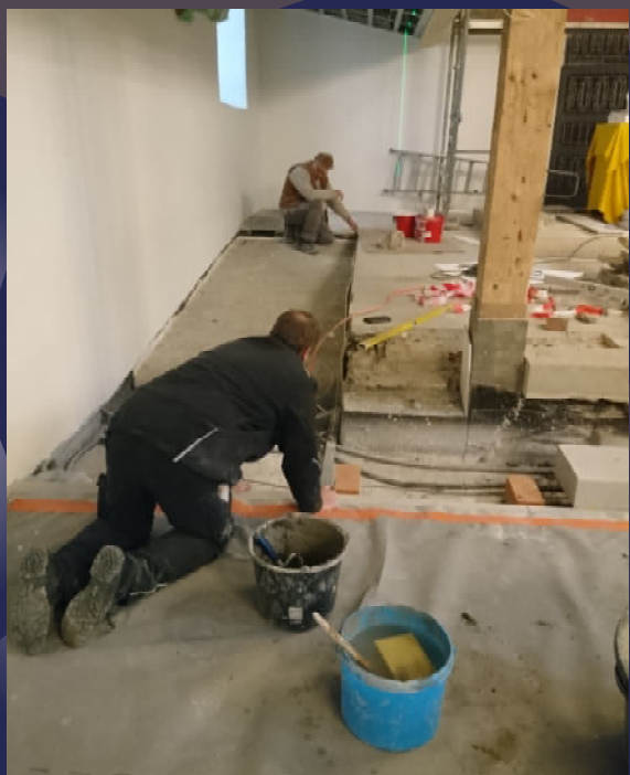
26. Oktober 2021 Blick auf die Arbeiten am Altarplatz
