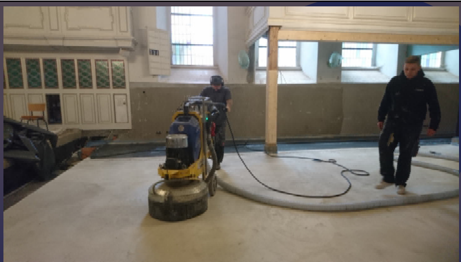
20. September 2021 Schleifen des Estrichs
