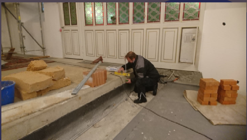
25. Oktober 2021 die Arbeiter der Firma Wiesner, Eppendorf beginnen mit den Verlege-Arbeiten des Sandsteins für den Altarplatz und die Stufen
