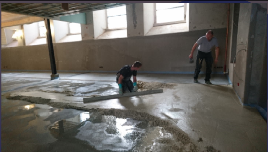
15. September 2021 die zweite Estrich-Schicht wird eingebracht
