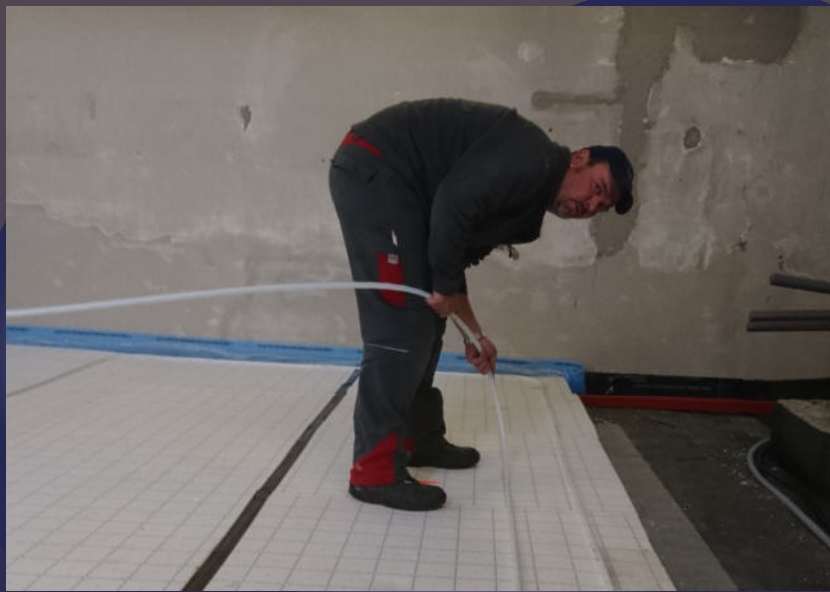
2. September 2021 Herr Gießner verlegt die Heizschlangen
