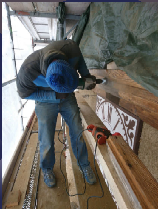
28. November 2020 Arbeitseinsatz Kirchturm
