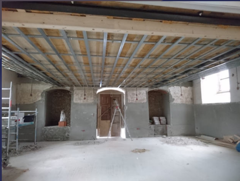
1. August 2021: Stand der Trockenbau-Arbeiten
