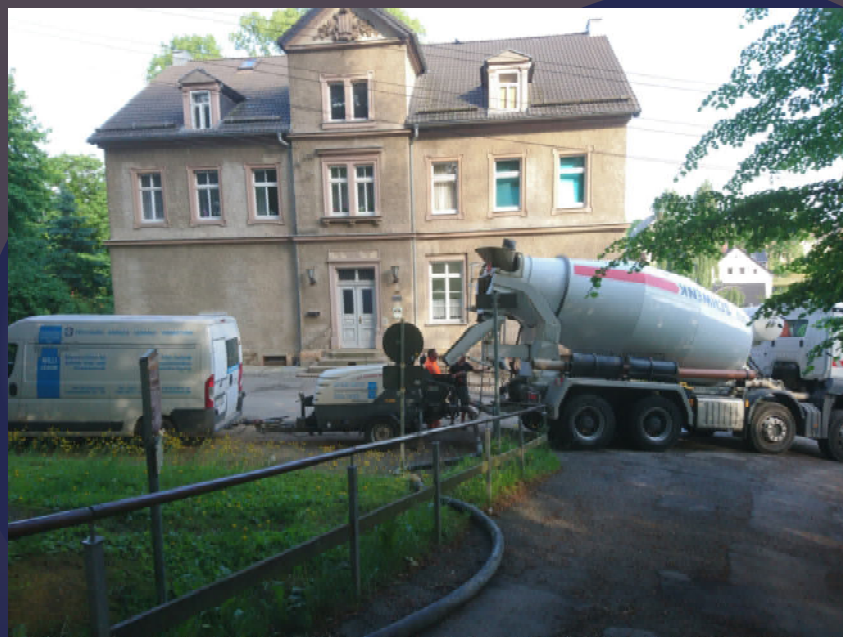
11. Juni 2021: Betonieren der Bodenplatte
