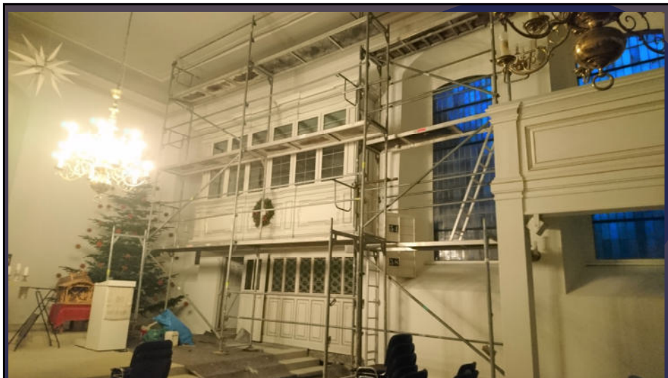
4. Januar 2022 das Gerüst steht wieder für die vorerst letzten Malerarbeiten im Kirchenschiff
