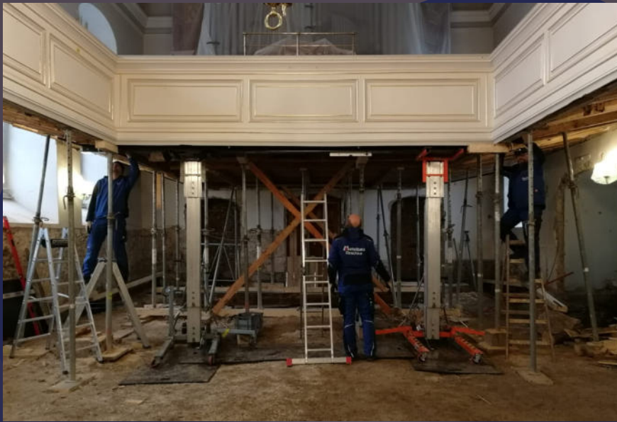
16. April 2021: Einbau der Träger
