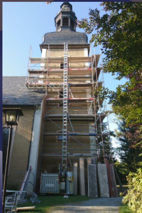
15. September 2020 Gerüstbauer der Firma Haustein stellen Gerüst am Turm
