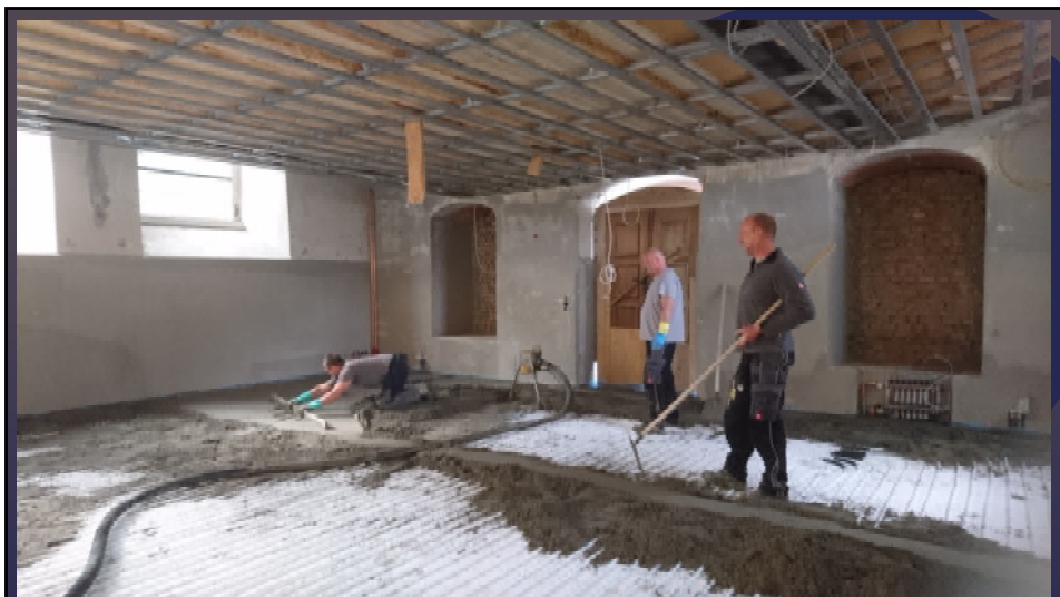
13. September 2021 die Arbeiten beginnen
