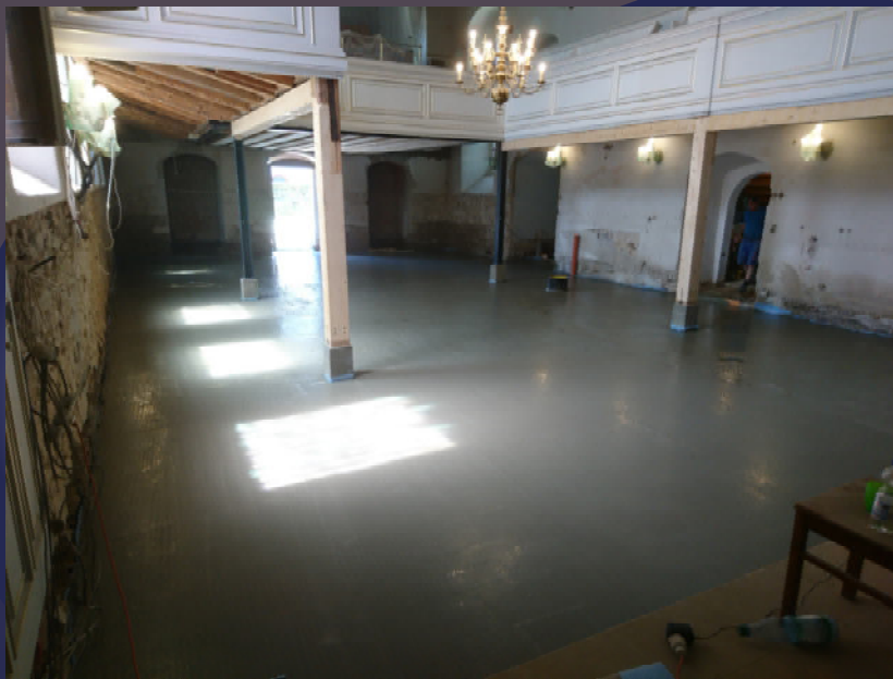
11. Juni 2021: Bodenplatte ist fertig
