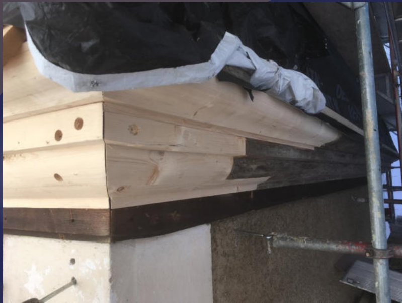
15. November 2020: Zimmererarbeiten Turm
