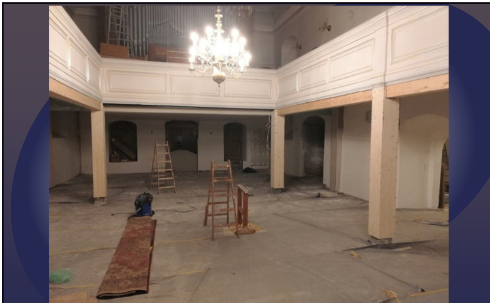
16. November 2021 Tischler haben Säulen und Balken verkleidet
