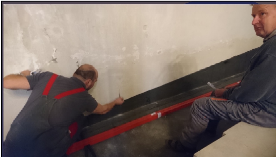
20. September 2021 Abstimmung zwischen Herr Gießner und Herrn Wiesner über die anstehenden Arbeiten Verlege-Arbeiten am Altarplatz
