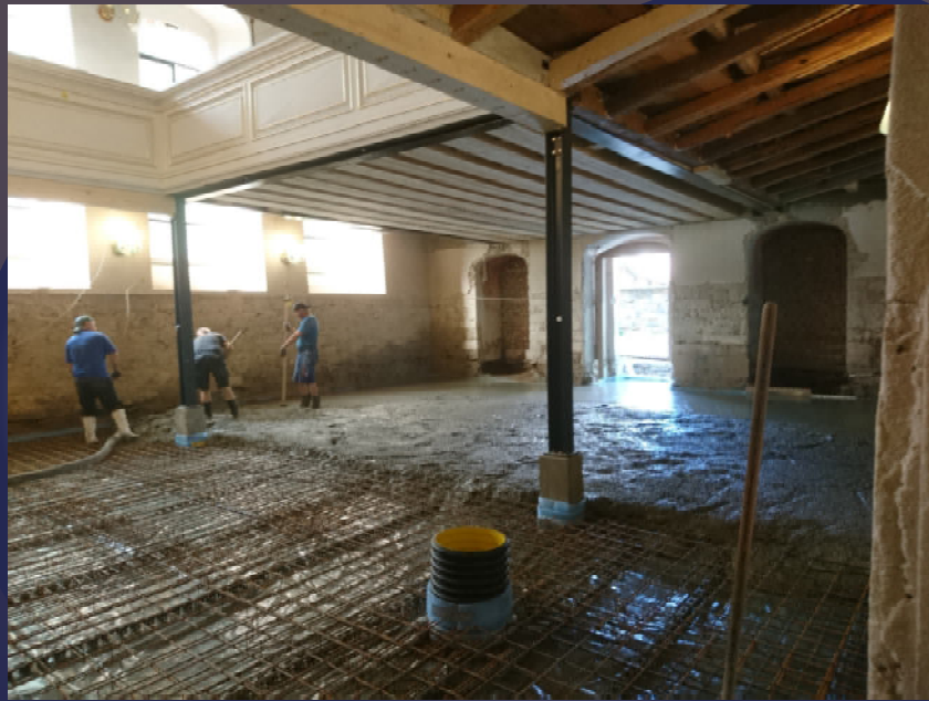
11. Juni 2021: Betonieren der Bodenplatte
