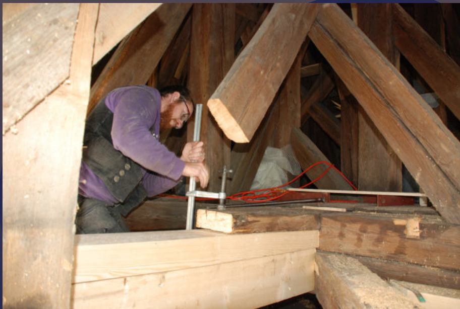
9. November 2020: Zimmerarbeiten Turm
