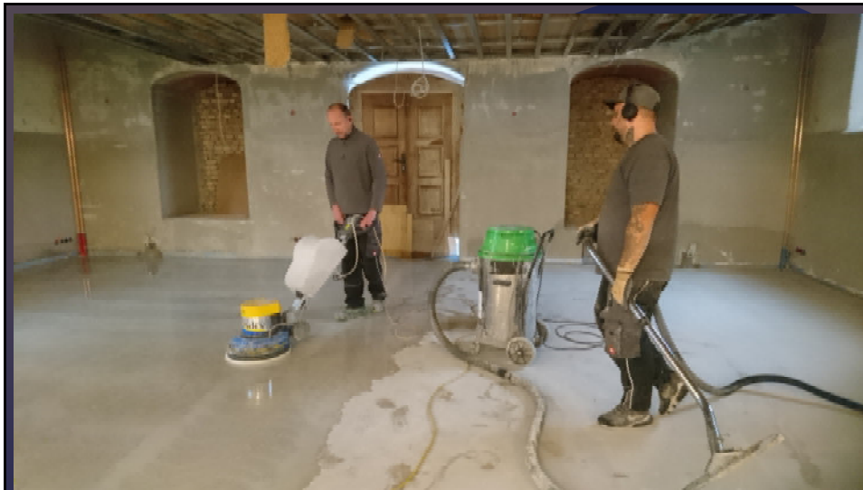
4. Oktober 2021 der Estrich muss noch einmal geschliffen werden
