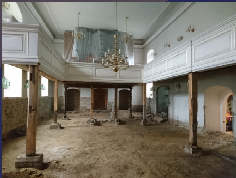
6. Februar 2021: am Ende des Arbeitseinsatzes
