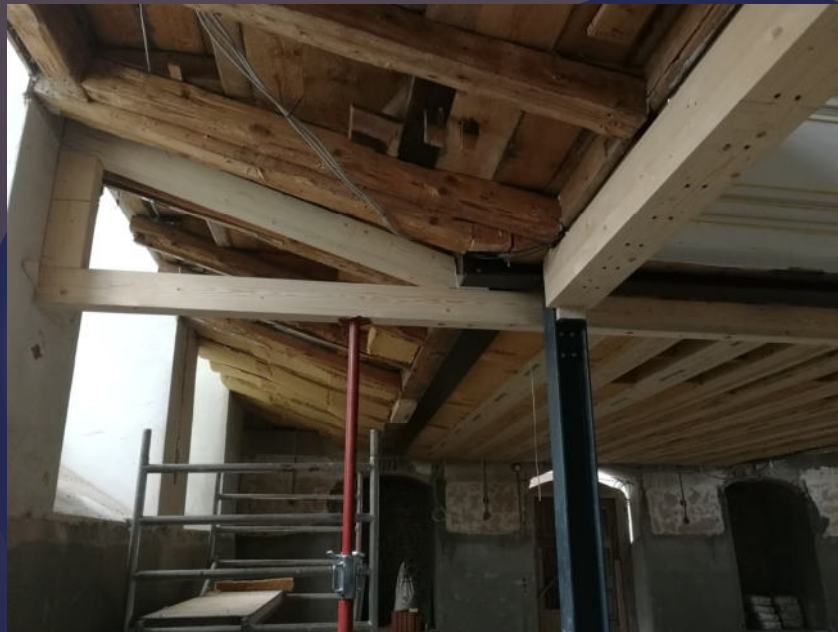
28. Juli 2021: Beginn der Arbeiten unter der Empore
