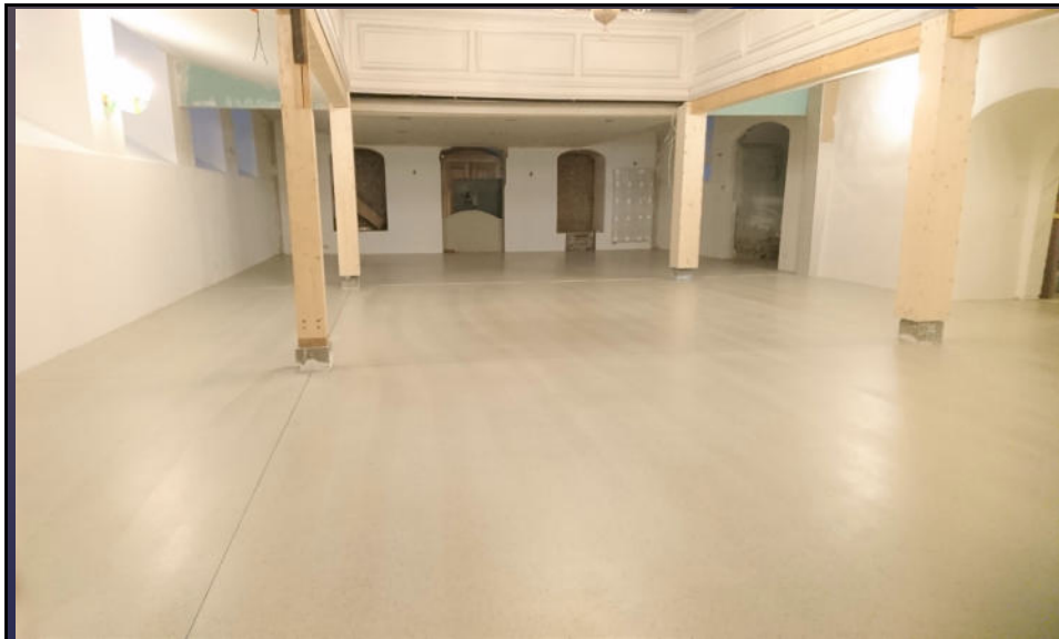
19. November 2021 der Estrich ist nun fertig versiegelt
