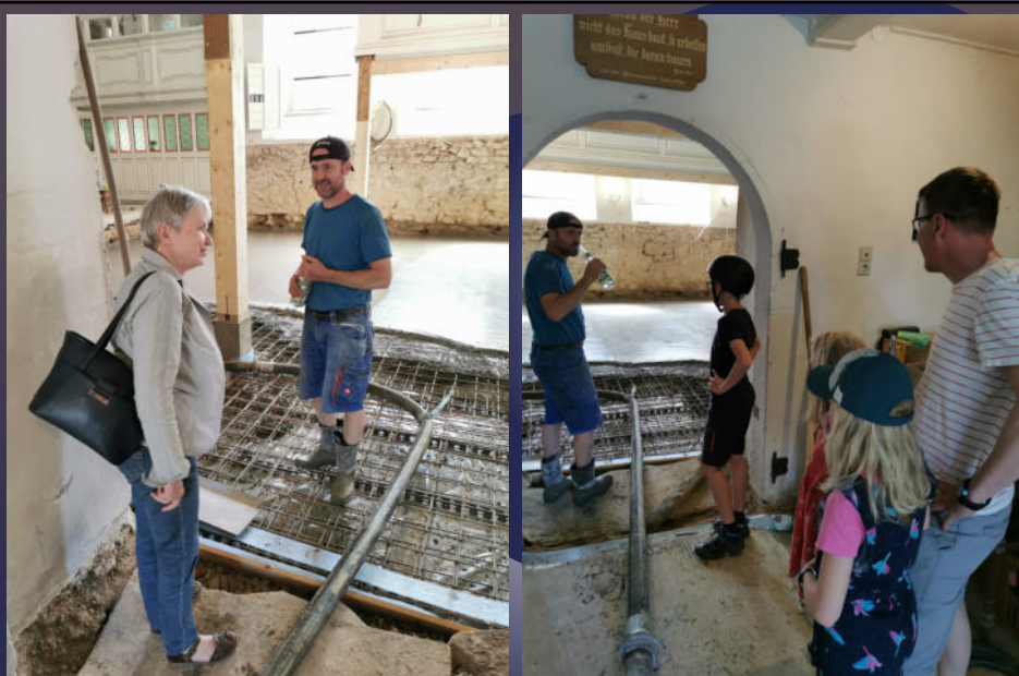
11. Juni 2021: Besucher auf der Baustelle
