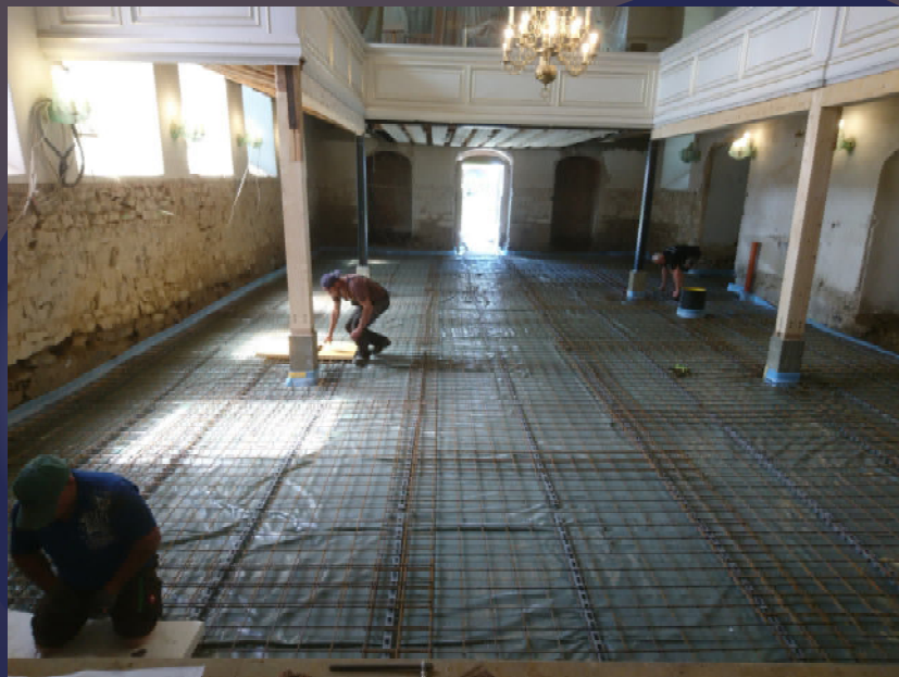
8. Juni 2021: die 1. Lage der Stahlmatten
