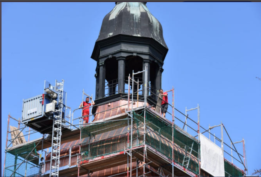
11. Mai 2021: Abrüsten Kirchturm
