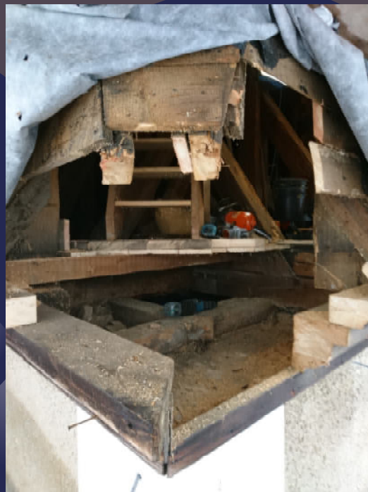
15. Oktober 2020 Zimmererarbeiten auf dem Kirchturm
